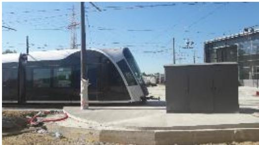
**Bild 2:** Kompakte Schaltschränke können überdimensionale Technikräume ersetzen und lassen sich an den Haltestellen und Bahnsteigen problemlos in die Architektur integrieren.
