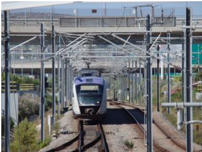
Bild 1: Die neuen Bahnübergänge auf der Hauptlinie im Großraum Athen sind mit leistungsstarken Sicherheitssteuerungen von HIMA ausgestattet.
